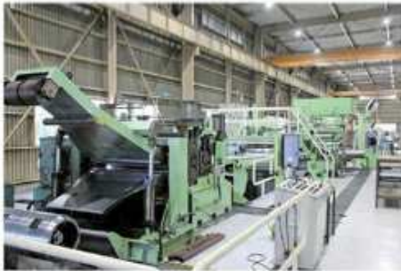
電気設備などを更新したスリッターライン
