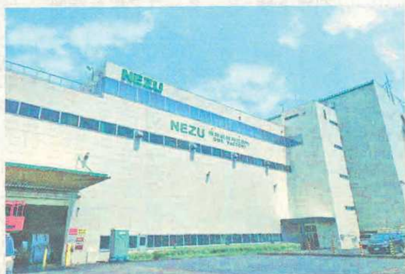
豊田通商系の旧関東コイルセンターは根津鋼材の 新「青梅事業所」に
