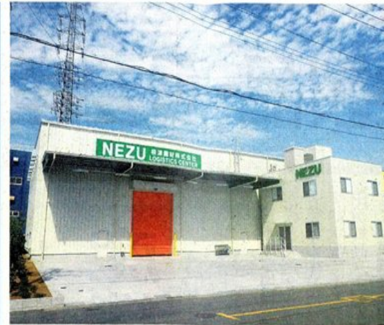
新設した八潮物流センター
